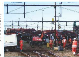
Demontering av Pågatågsstationen pågår för fullt. Foto: Tore Ellering
